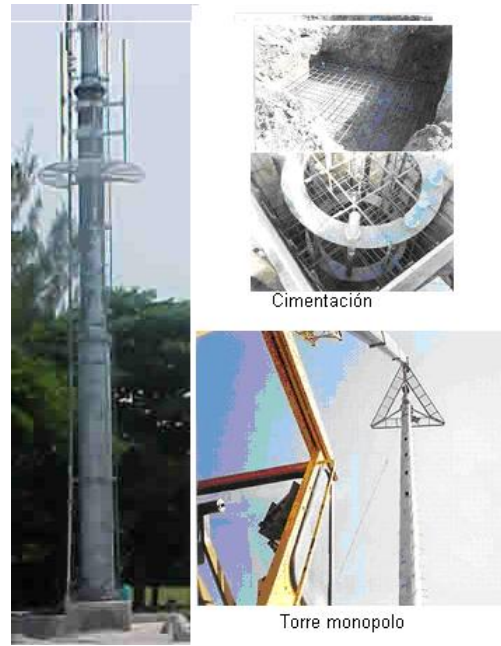
Figura 4.10: Torre monopolo y su Cimentación
