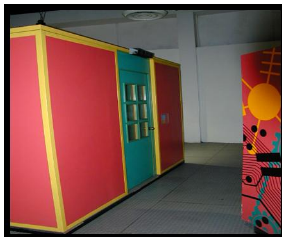
Figura 5.2 Frente Cabina de Radio.
