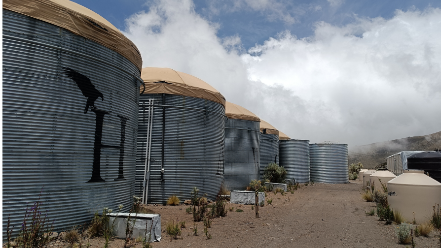
Figura 2.1: Detectores Cherenkov de agua del observatorio HAWC. La experiencia operativa obtenida con este tipo de detectores motivó el desarrollo de sistemas para el monitoreo continuo del nivel de agua. Fotografía tomada por el autor.
