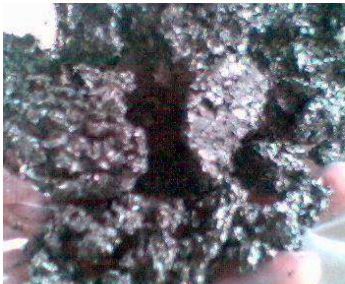
Figura 9.46 Falla en el mezclado.
