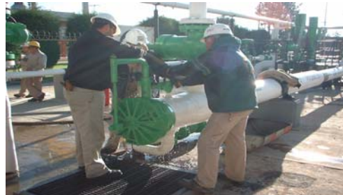
Figura 3.14 Envío convencional del DIM. Fuente: http://www.girard.com/valves-launching.html , Foto tomada en instalaciones de PEMEX durante el envío de un DIM
