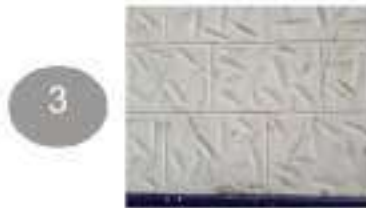
3 Agitaciones por asentamientos diferenciales: Asentamiento de la edificación en general.
