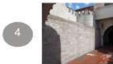
4 Elementos fuera del contexto arquitectónico: división de espacios, montaje de objetos y construcción no relevante.
