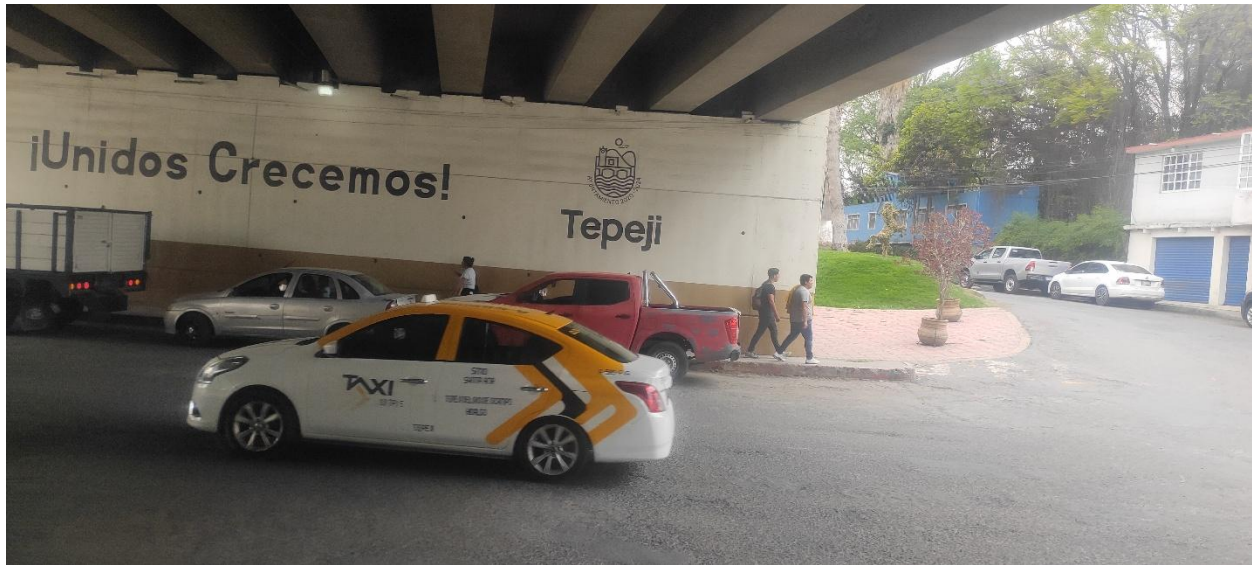
Fotografía 2.- Cruce entre carretera Tula - Tepeji, 2024.
