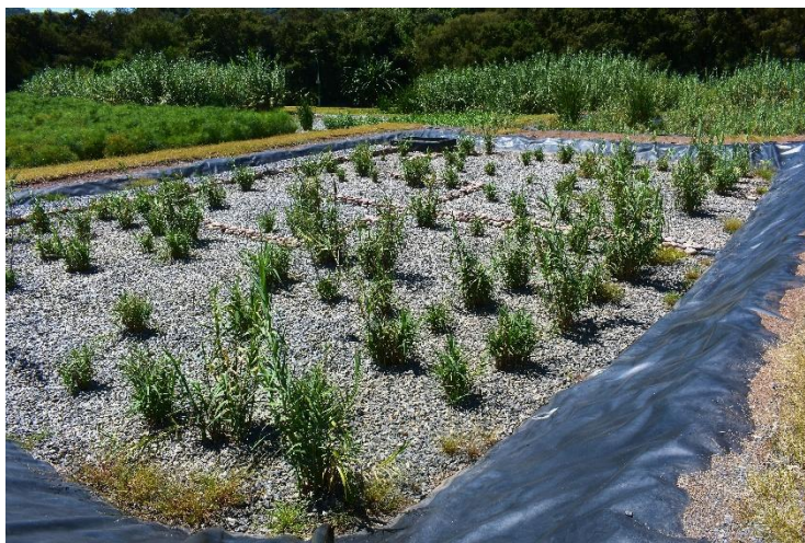
Figura 3.B: Humedal artificial de flujo subsuperficial horizontal.
