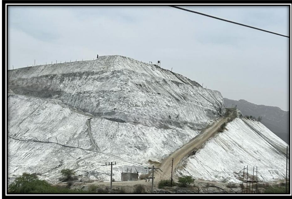
Figura 15. Presa de jales. Fuente: Elaboración propia 2025..
