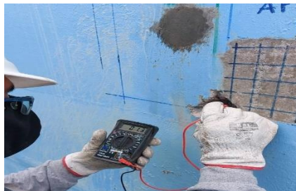
Figura 11. Medición de potencial de corrosión por CJE Ingenieros. (2018).
