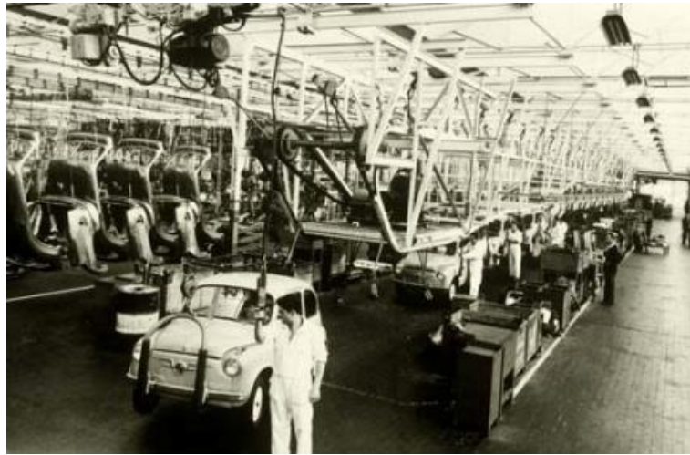
Figura 1.1. Cadena de montaje de la Zona Franca de Martorell.
