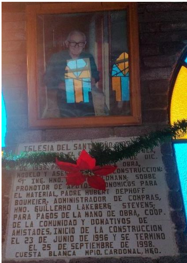
Figura 30. Pared lateral derecha, placa conmemorativa a la construcción de la capilla (Foto: García, diciembre 2022)
