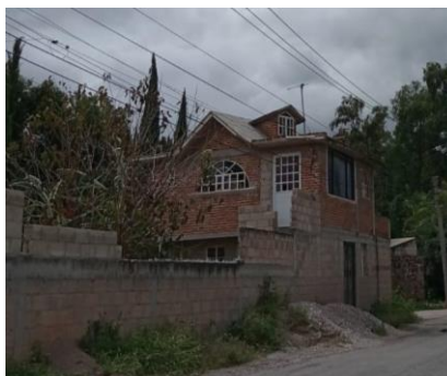
Figura 1.16. Construcción de ladrillo en la zona
