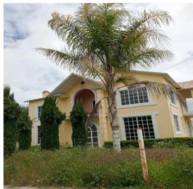
Figura 1.23 Construcción de nivel alto
