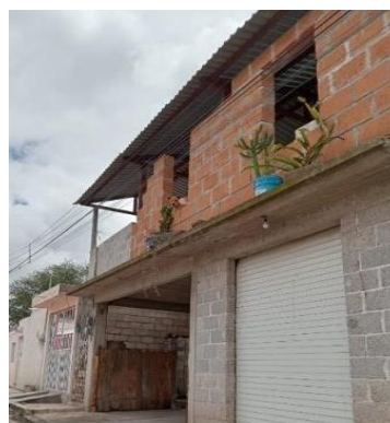
Figura 1.18 Construcción de lámina en la zona
