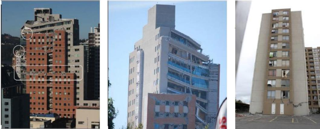
Figura 2.4 Colapsos parciales y daños graves en edificios con combinaciones de irregularidades en planta y elevación (Colunga, 2010)
