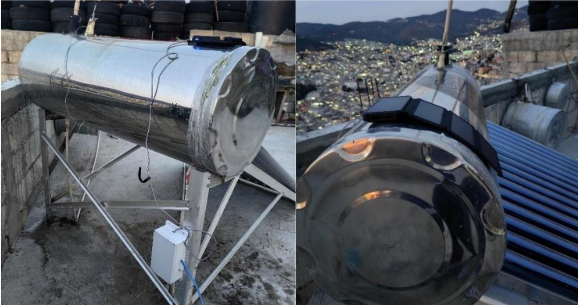
**Figura 34.** *AquaSensolar instalado en un calentador solar y con el panel solar*
