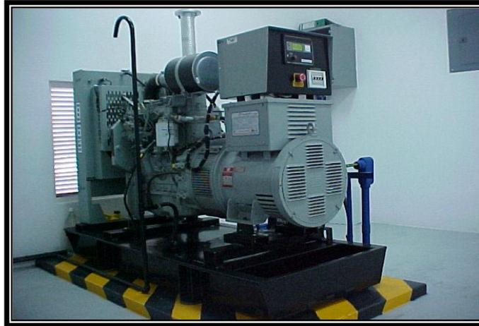
**FIG. 3.6 LA PLANTA DE EMERGENCIA**
