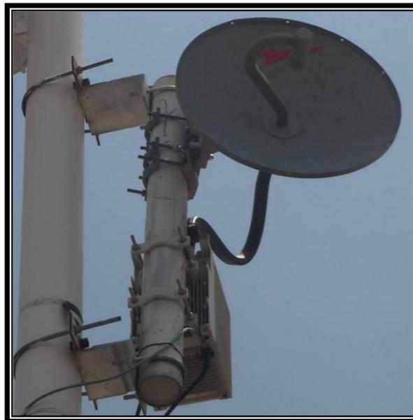
**FIG. 3.2 ANTENA TIPO REFLECTOR PARABOLICO**
