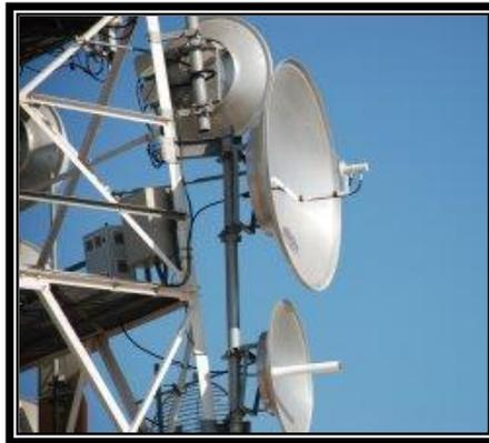
FIG. 1.22 ANTENA TIPO REFLECTOR PARABÓLICO
