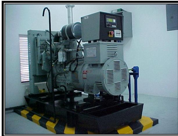
FIG 1.33 PLANTA GENERADORA DE ENERGIA ELECTRICA
