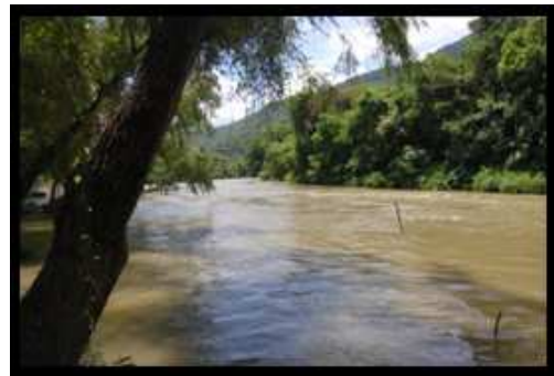
Figura 16. Estructuras en el cauce del río en Plan de Ayala.
