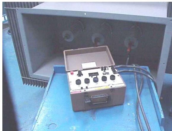
Fig. 3.20 Dispositivo de medición de relación de transformación
