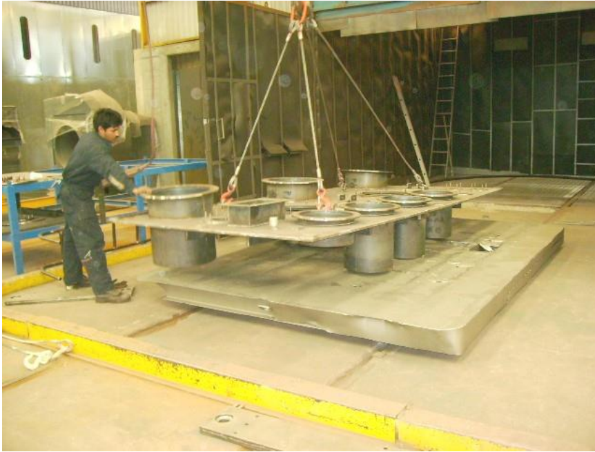
Fig. 3.12 cámara de granallado
