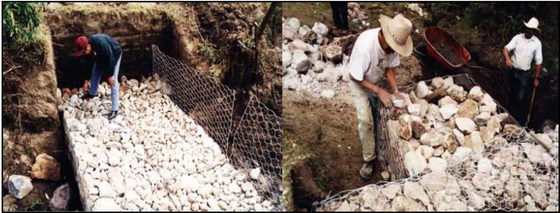
Fig. 3. 15 Construcción de la presa de gaviones
