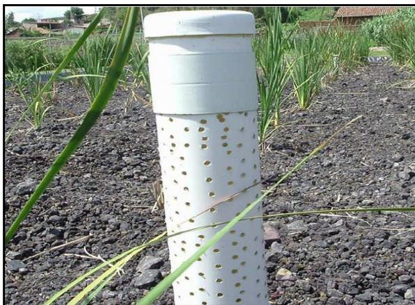
Fig. 5. 6 Ejemplo de un tubo perforado para aireación del humedal
