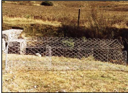
Fig. 3. 14 Muestra de un gavión. Fuente Gaviones LEMAC
