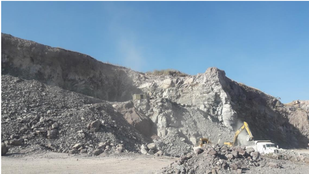
Figura 4.2. Banco de material de agregados pétreos en San Gabriel Chilac.
