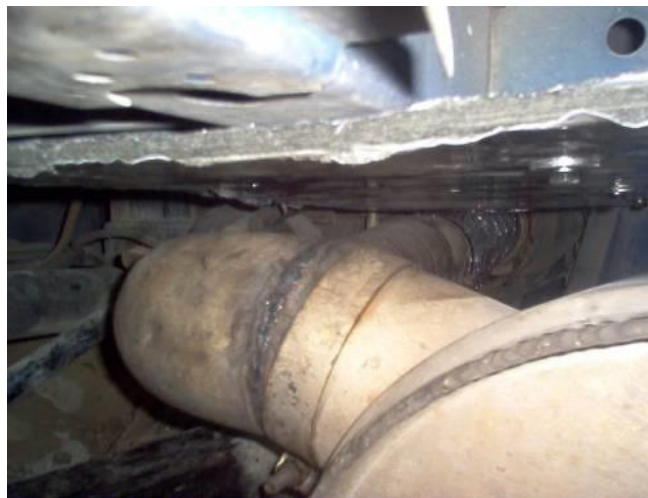
Figura 51. Después: corte y unión, soldadura autógena codo entrada silenciador
