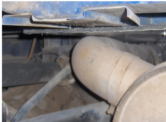
Figura 50. Antes: la tubería del sistema de escape se posicionaba a una mínima distancia
