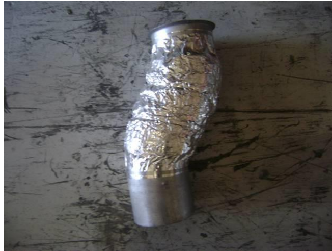
Figura 40. Aislamiento del tubo
