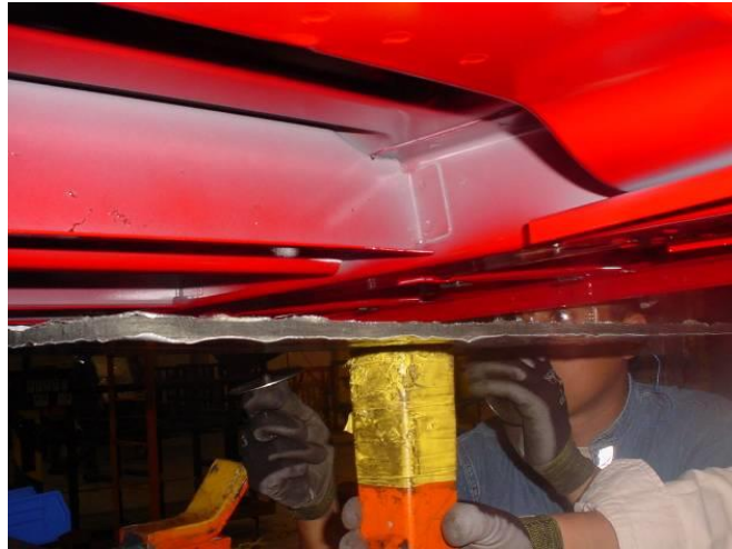
Figura 44. Instalación aislante térmico
