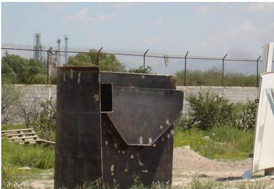
Fig. 2.8.- Pozo de alimentación y la canaleta para el derrame de agua.
