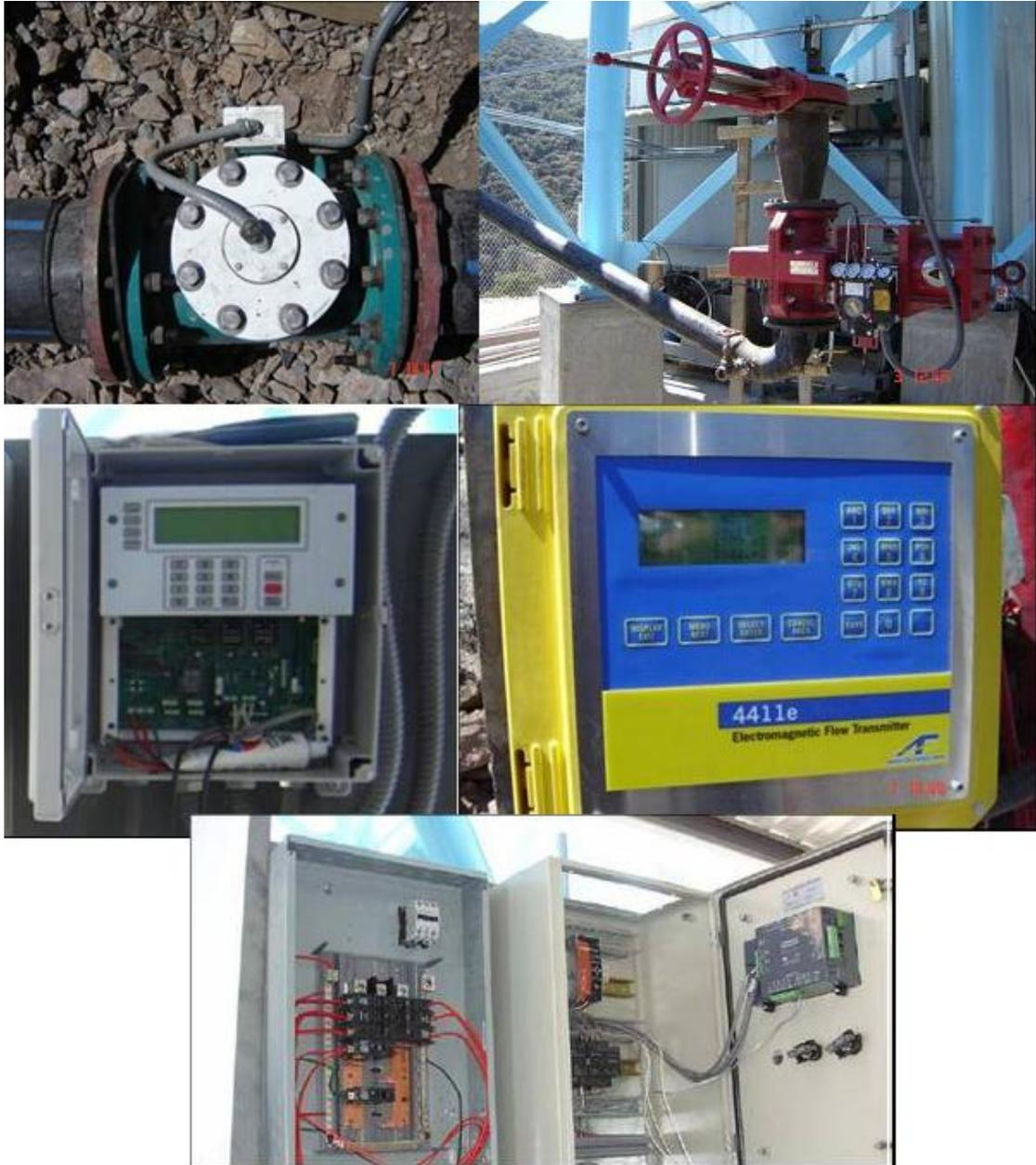
**Fig. 2.15.- Instalación de la válvula de descarga de sólidos, transmisor del flujo metro de alimentación y flujo metro de derrame de agua, todos conectados al panel de control.**
