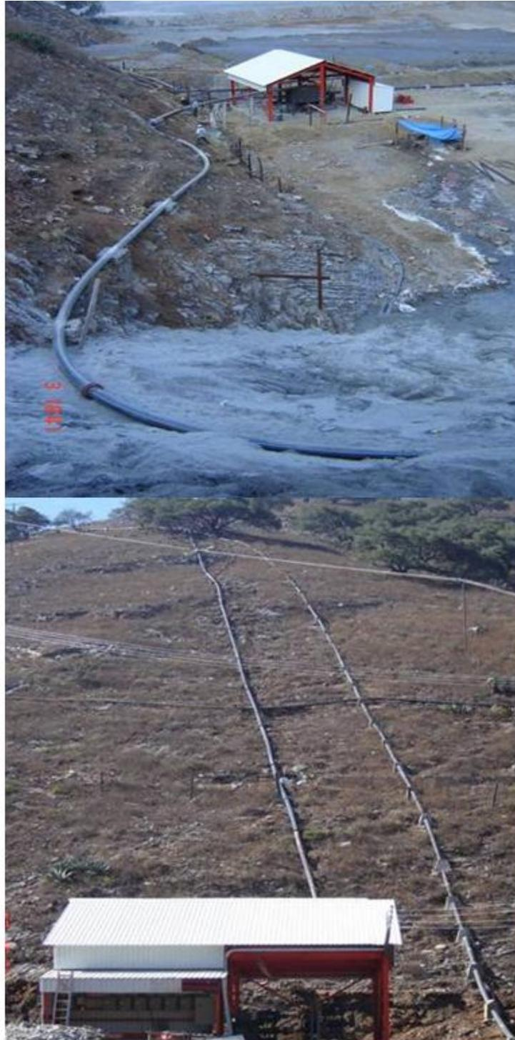
Fig. 2.20.- Línea de finos a la estación de bombeo y línea de alimentación al tanque E-CAT y retorno de la descarga.
