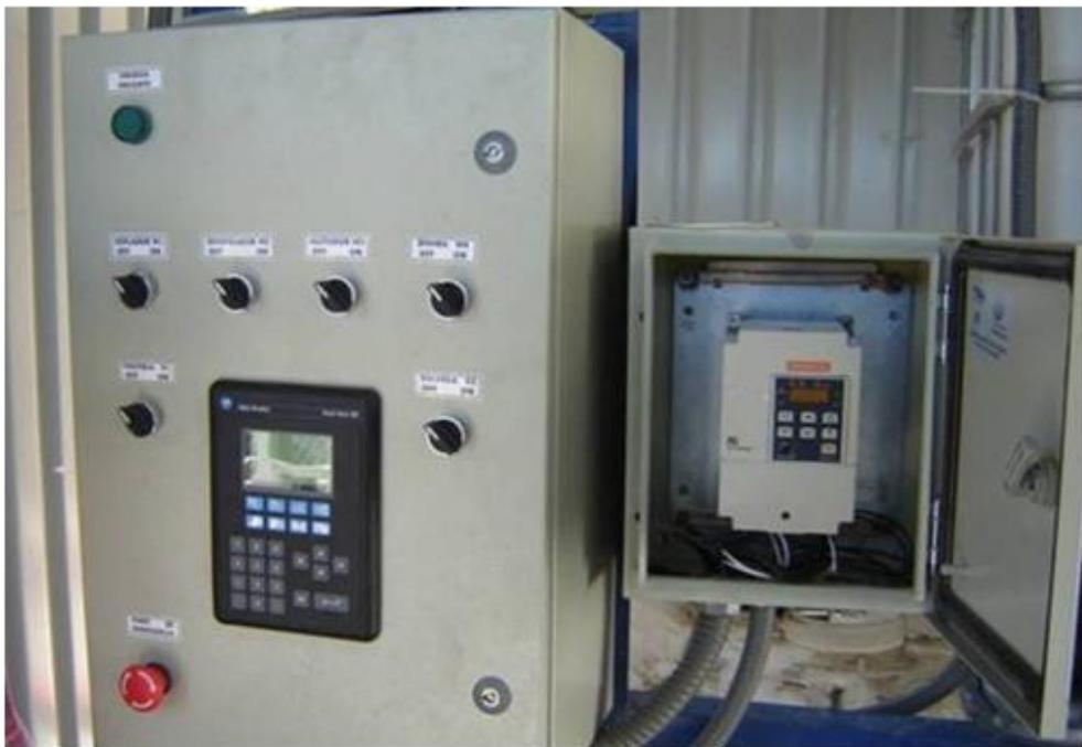
Fig. 2.17.- Instalación del sistema de control automático de la preparación y dosificación de floculante.
