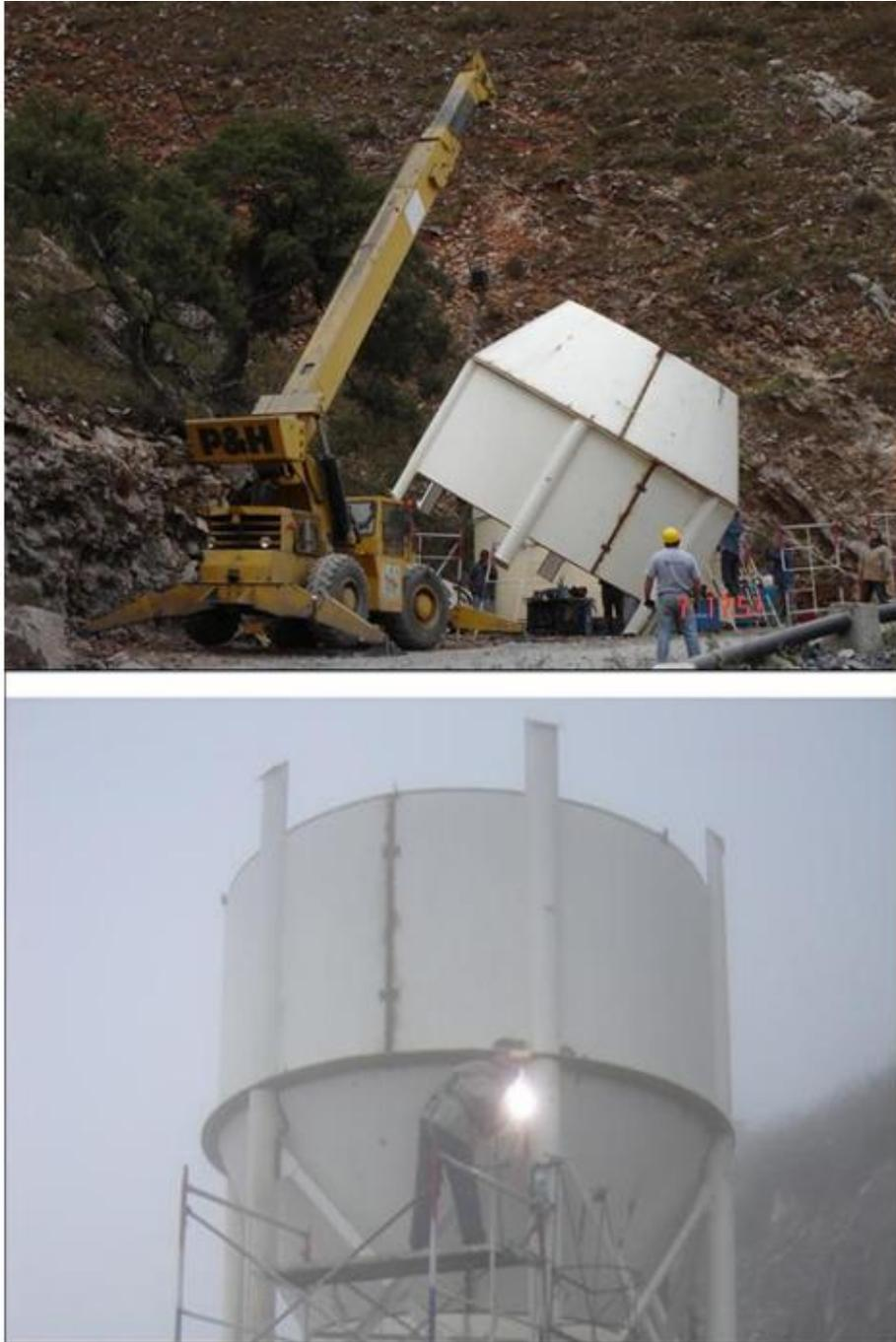
Fig. 2.5.- Instalación del tanque Clarificador-Espesador E-CAT.
