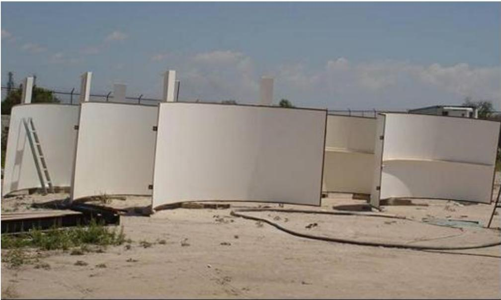
Fig.2.4.- Partes del cilindro que formará el exterior del tanque E-CAT.
