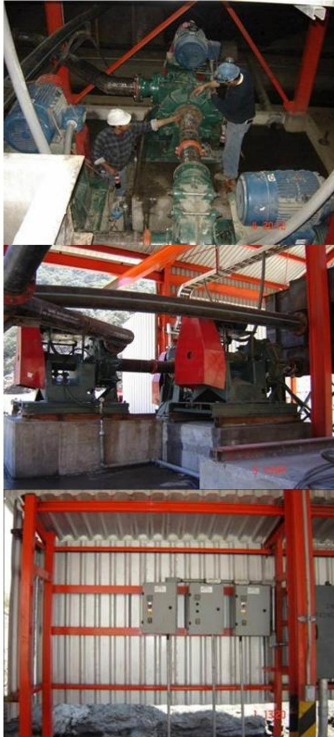
Fig. 2.19.- Instalación de las bombas en serie junto con sus arrancadores a tensión reducida.
