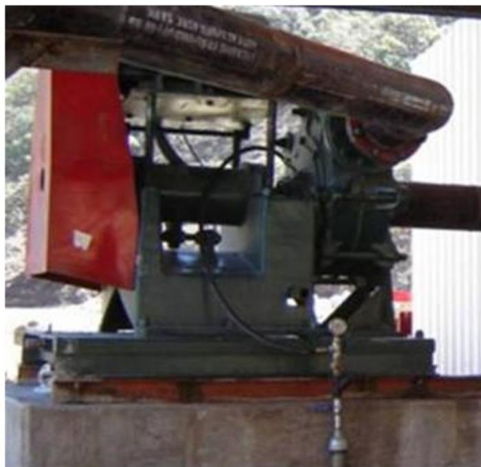
Fig. 3.2.- Bomba centrífuga en la estación de bombeo de finos para la alimentación al tanque E-CAT.
