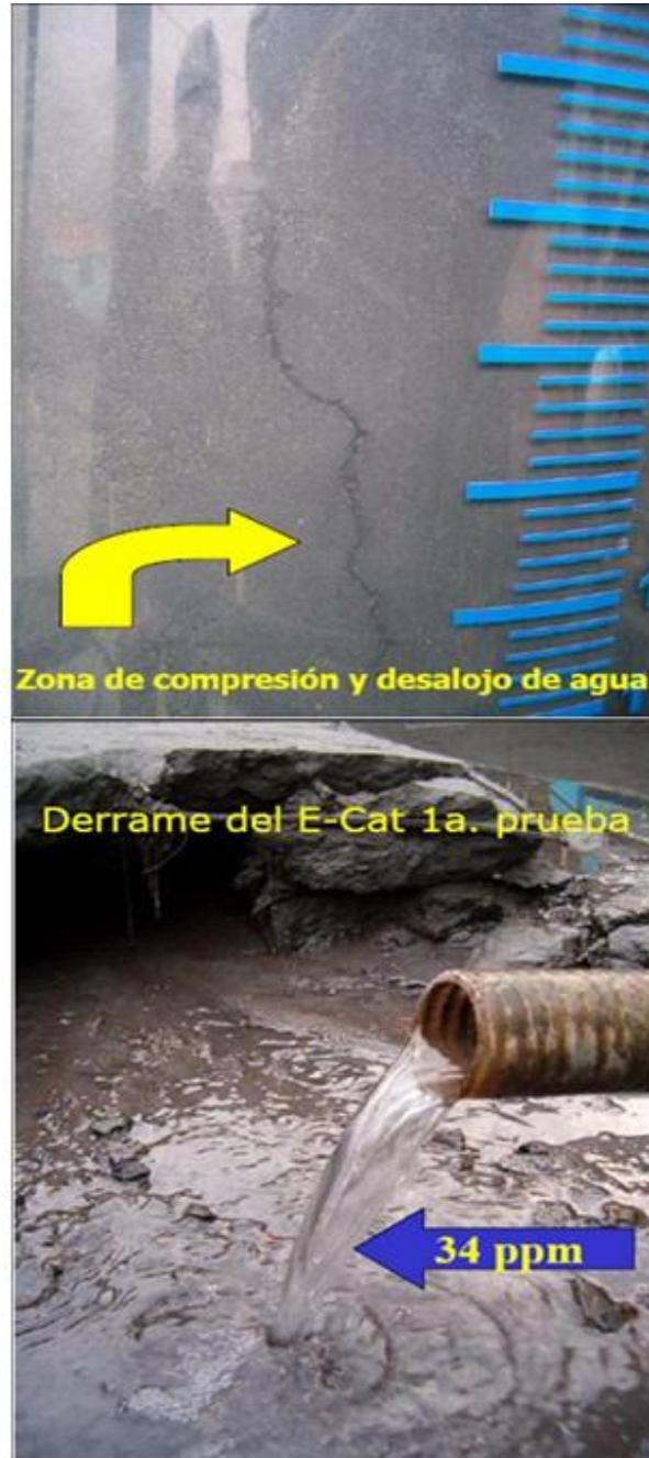
Fig.19.- Zona de compresión, desalojo de agua y derrame del E-CAT en el primer día de pruebas con una turbidez de 34 ppm.
