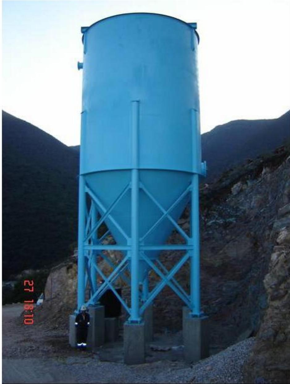
Fig. 2.11.- Tanque Clarificador-Espesador E- CAT una vez que ha sido ensamblado.
