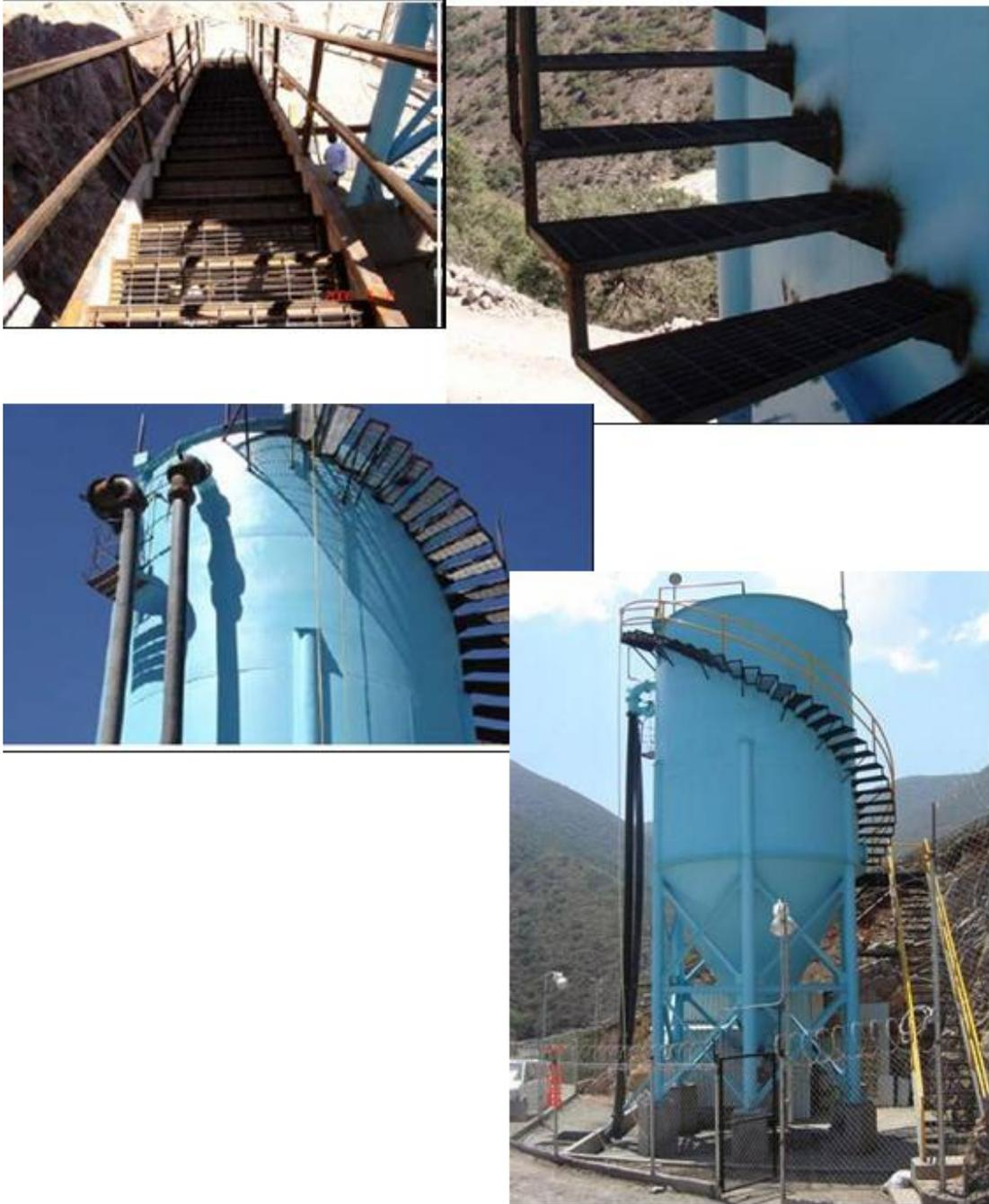
**Fig. 2.21.- Instalación de escaleras y barandales para acceso hacia el tanque Clarificador-Espesador.**
