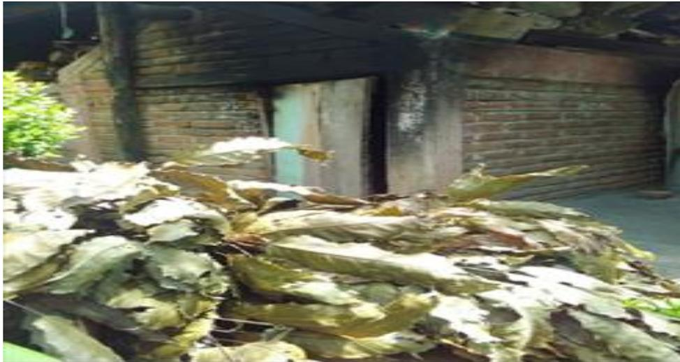
La estructura es en forma de una pequeña casa cuadrada, con medidas de aproximadamente 1m de largo por tres de ancho; hecha de cemento, la cual cuenta con una pequeña chimenea que permite la salida del humo, la cual posteriormente durante el baño de vapor será cerrada para que
