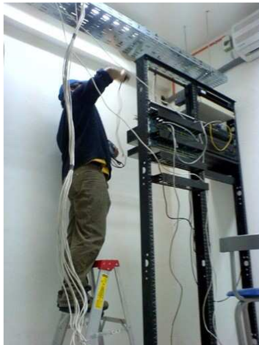
Figura A.6 Montado del rack
