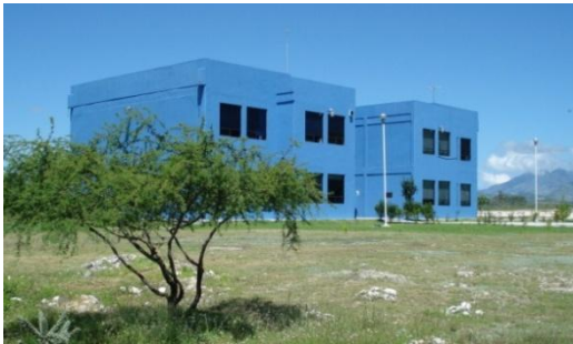
Imagen 2 Edificio principal de la ESZI 1 Fuente: Archivo de la ESZI
