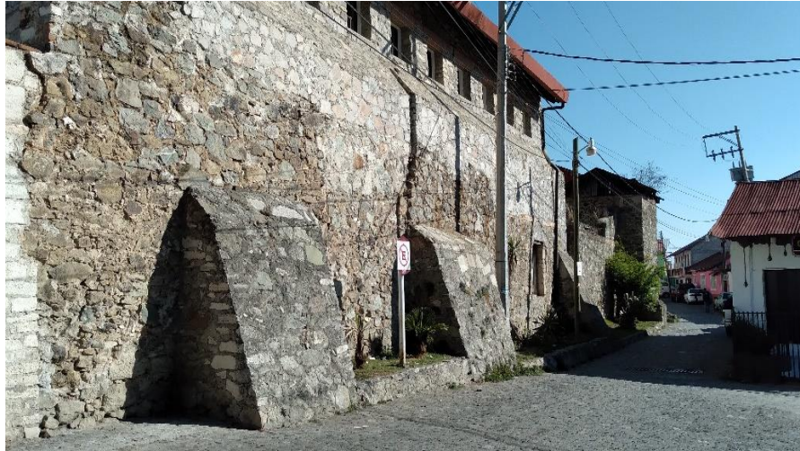
Imagen 29. Vista de los contrafuertes. Exterior de San Cayetano por calle Narciso Mendoza. Foto. Rosa Guadalupe Gómez Quinto. 2021.
