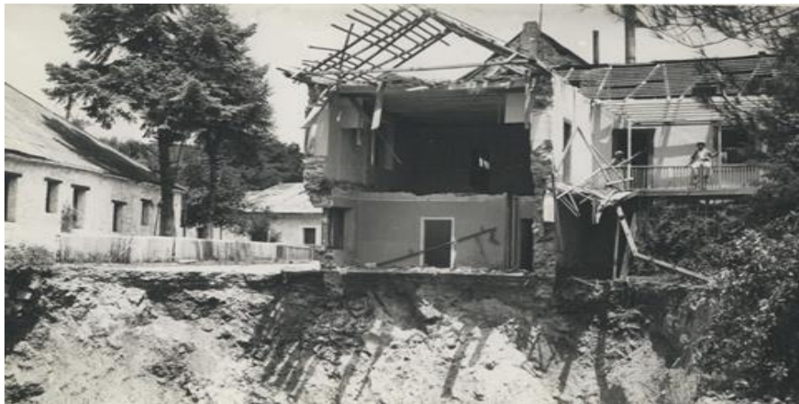
Imagen 14. Interior de San Cayetano. Derrumbe de viviendas. Col. Lic. Juan Randell Badillo. 3/junio/1964
