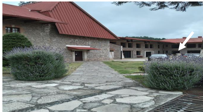
Imagen 24. Vista interior módulo G, talleres de grabado, pintura en caballete, escultura en metal y piedra, cubículos para investigadores del Instituto de Artes. Foto. Rosa Guadalupe Gómez Quinto. 2021.
