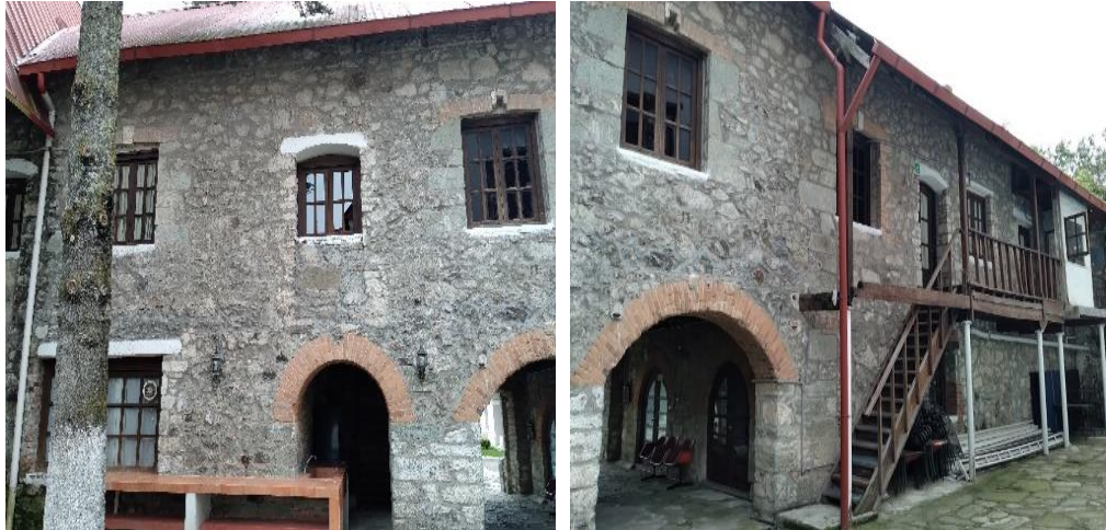
Imagen 26. Vista posterior del módulo D, edificio principal de San Cayetano. Foto. Rosa Guadalupe Gómez Quinto. 2021.
