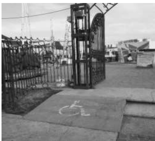
Fotografía 11. Pavimento y mobiliario urbano.
