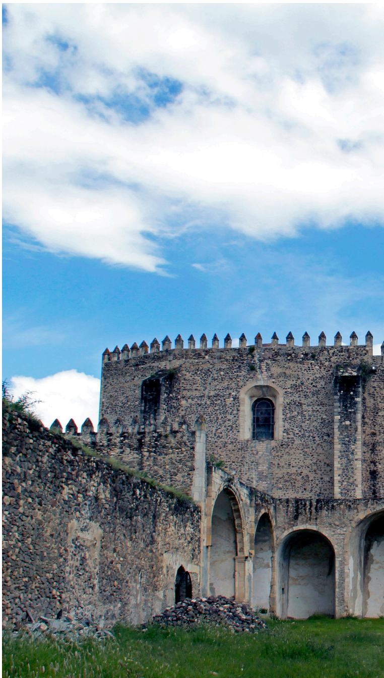
Metztitlán: La iglesia vista desde el costado poniente.
