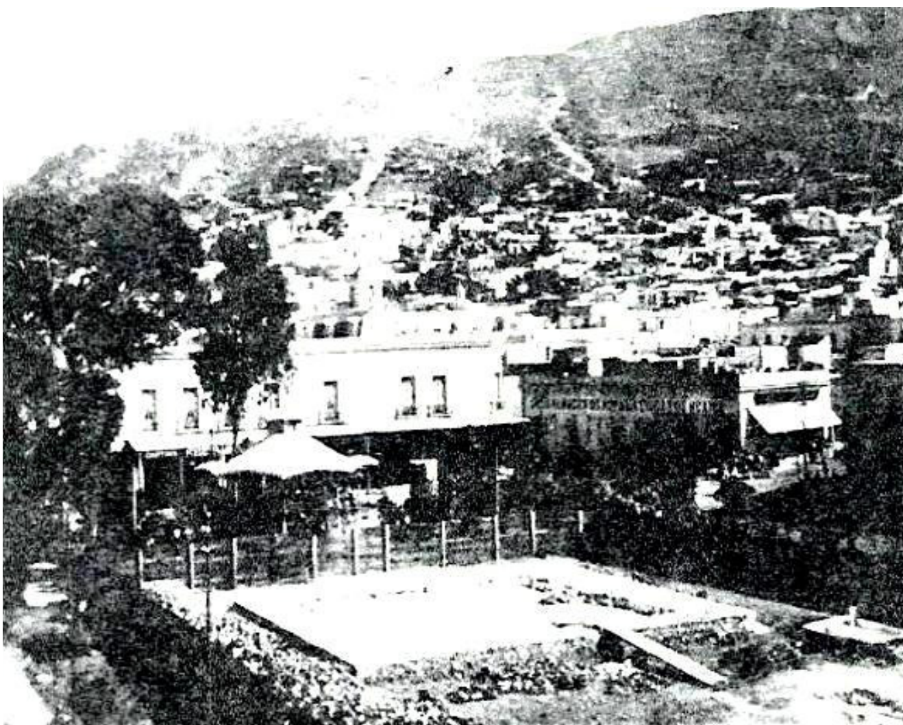
Zócalo o cimiento de donde se desplantó el monumental Reloj. Véase la tapia que rodeaba la obra.
