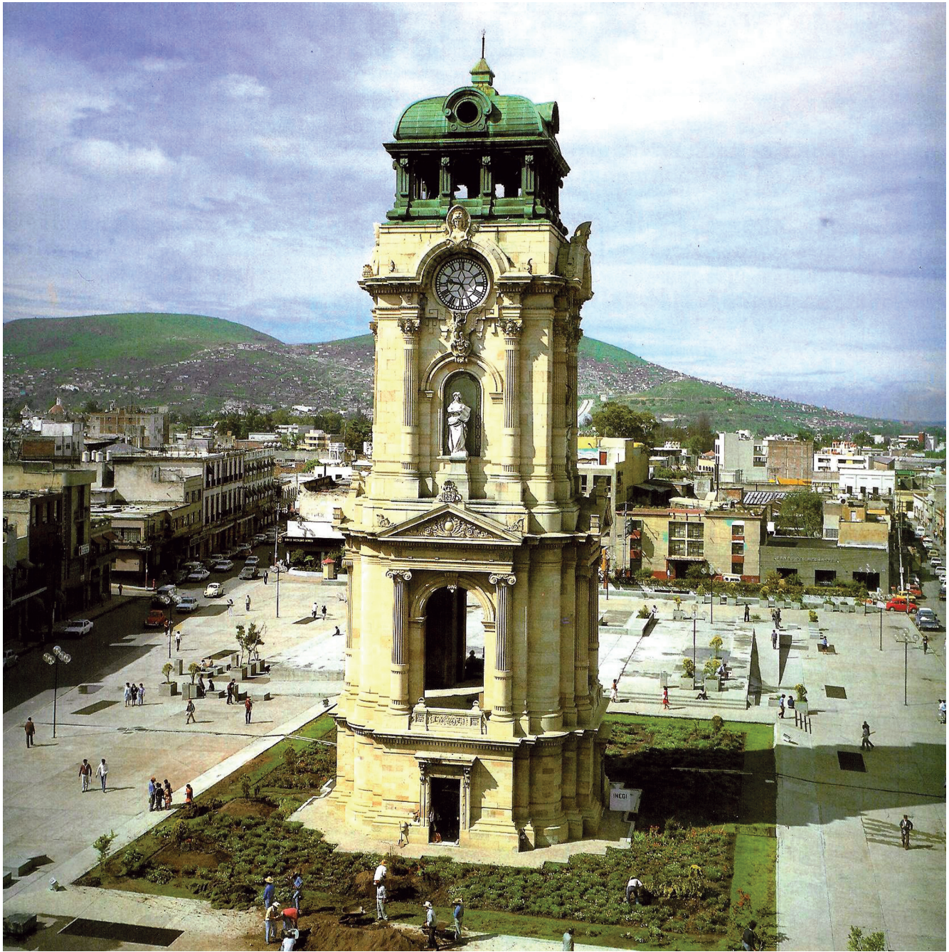
Plaza Independencia y monumento al terminar la obra del estacionamiento subterráneo y demolición del Edificio Reforma.
