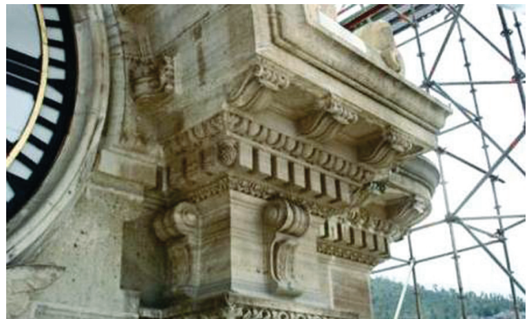
La cantera se limpió y se resanaron las juntas.
