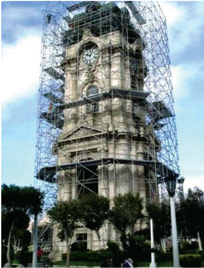
El Reloj rodeado de su andamio para la obra de la restauración.
