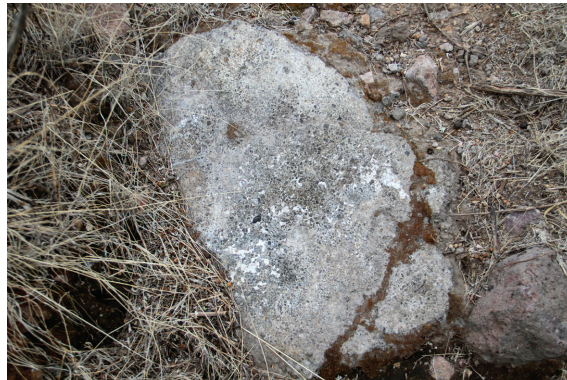
Talud de una construcción
