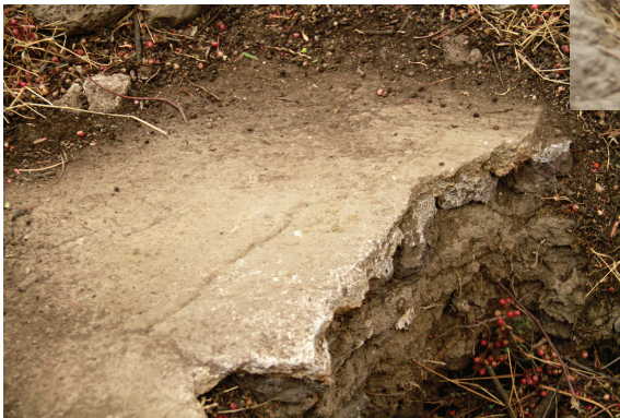
Piso y muro con aplanado de estuco
