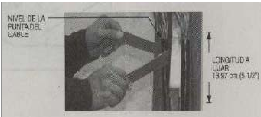
Figura 3.205. Lijado de la Cubierta Exterior de los Cables.
