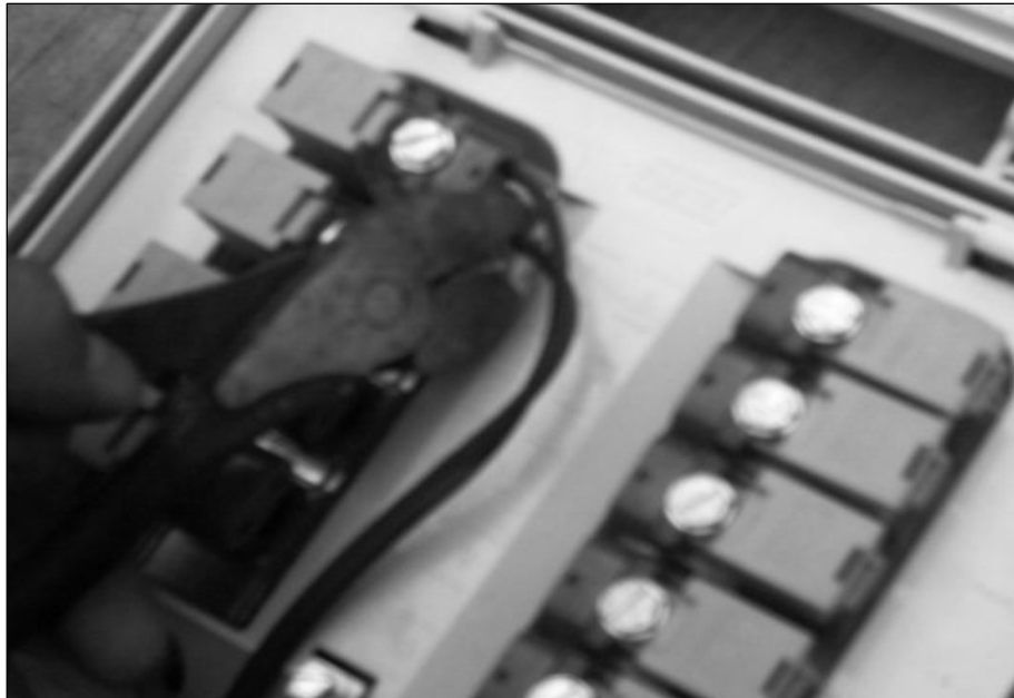
Figura 3.119. Realización del Cortar los Conductores Lado Linea.
